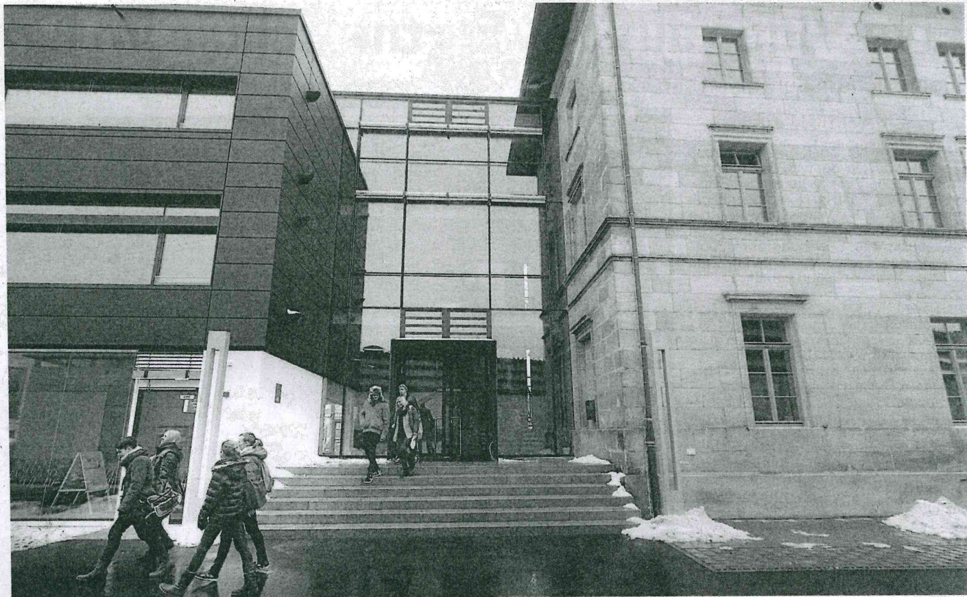
Ein moderner Neubau dockt an den alten Nürnberger Ostbahnhof aus dem Jahr 1874 an: Die neue Montessori-Fachoberschule an der Dr.-Carlo-Schmid-Straße steht unter dem Motto: „Das Alte bewahren, das Neue ermöglichen.“ Foto: Weigert
